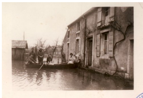
Mémoire collective - crue de 1955 à Labergement-les-Auxonne (21)
