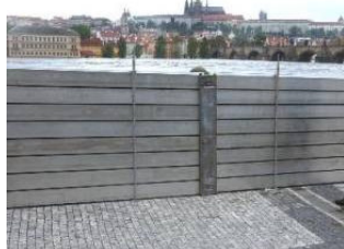
Exemple de mur – batardeau amovible
