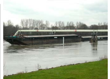
Passage d'un convoi sur les clapets baissés à Dracé (situation observée environ 50 jours par an)
